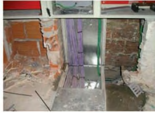
l) Canal OQA - QDR4- listo para recibir cajas portamecanismos
