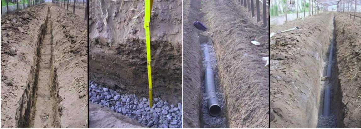
Figura 14 Drenes instalados en campo de productor
